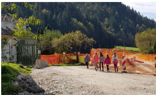
Gradbišče pri šoli
